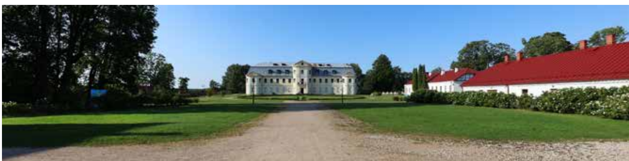
Attēls Nr.15. Daļa no grāfu Plāteru 18. gs. celtā pils kompleksa Krāslavā.
