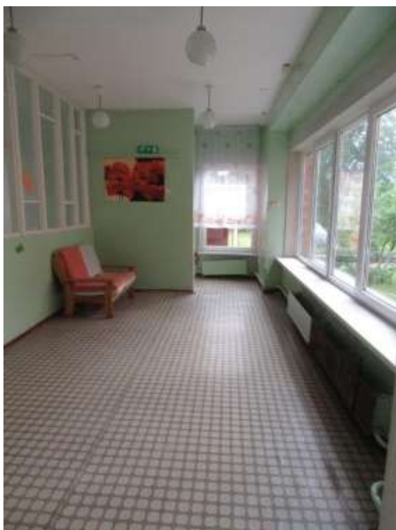
19.attēls. 4. korpusa 1. stāvs vēl neizremontētās telpas
