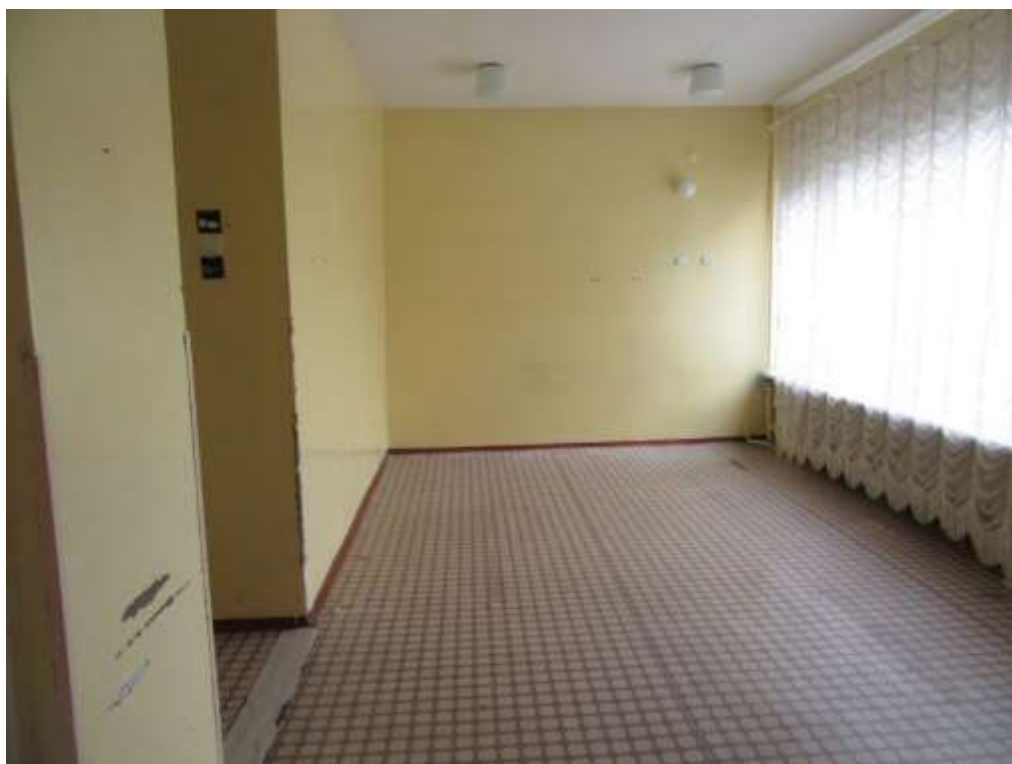
20.attēls. 4. korpusa 1. stāvs vēl neizremontētās telpas
