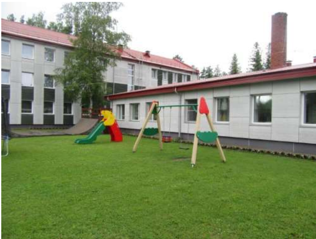
3.attēls. Bērnu nama ēka, virtuves bloks un bērnu rotaļu laukums (daļēji)
