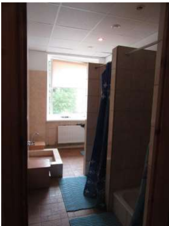
13.attēls. Sanitārais mezgls trešajā stāvā
