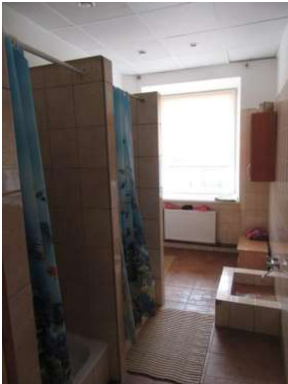
6.attēls. Sanitārais mezgls otrā stāvā
