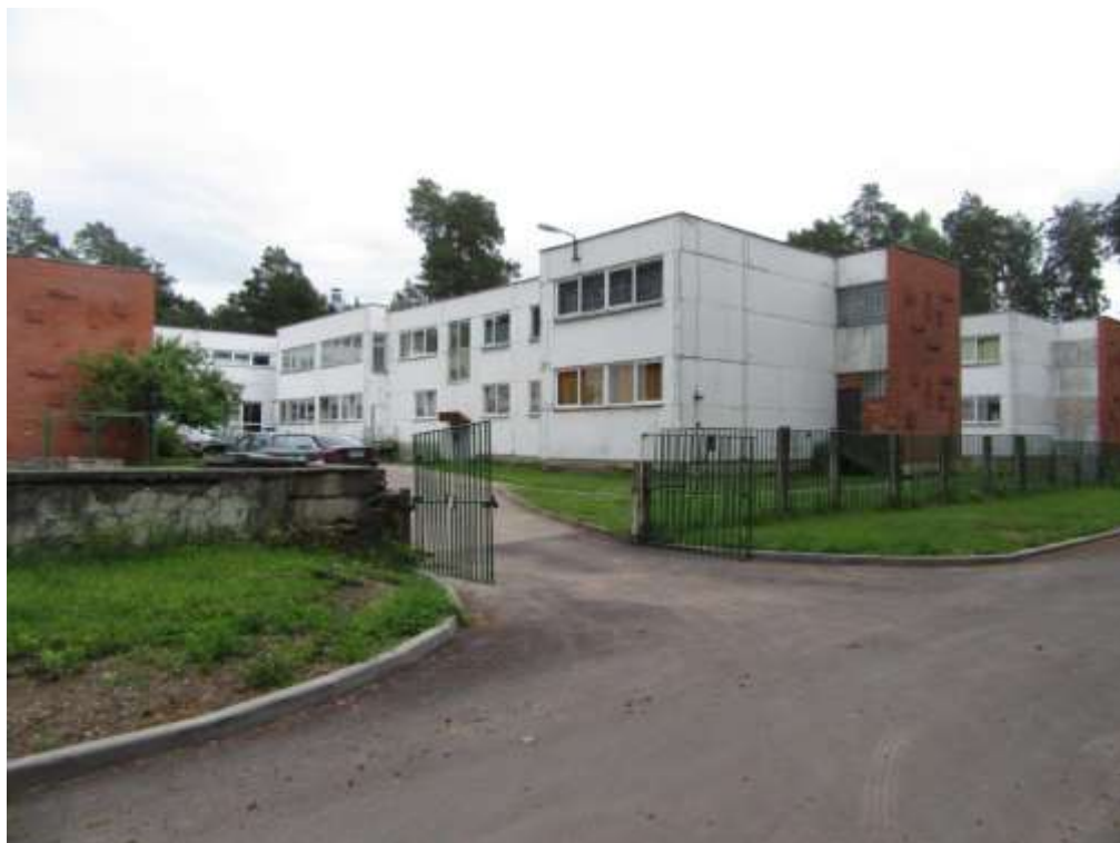
1.attēls. Bērnu nama ēkas fasāde
