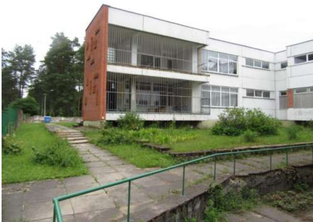
2.attēls. Bērnu nama ēkas fasāde (dažās telpu grupās ir lodžijas, kas aprīkotas ar režģiem)
