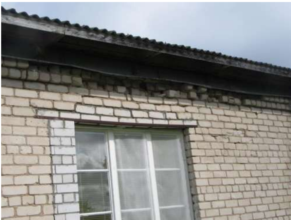
9.attēls: Bojātās un atjaunotās virtuves bloka sienas
