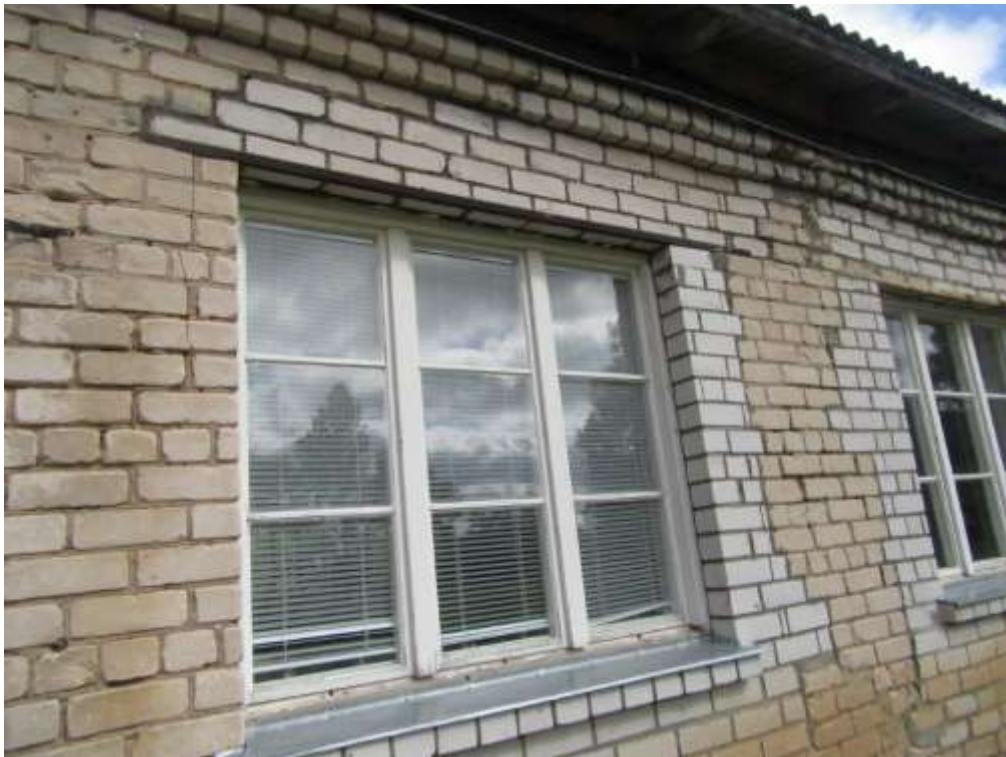
7.attēls: Bojātās un atjaunotās virtuves bloka sienas
