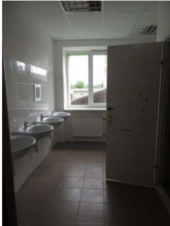
21.attēls: Sanitārais mezgls ēkas 2. stāva kreisajā spārnā
